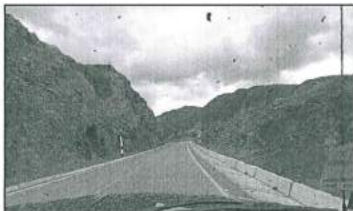
Foto 1: Carretera a Llama y La Colmena.
