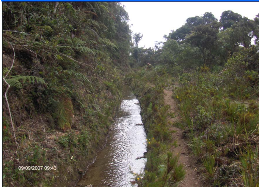
FOTO 3: Canal Ocshawilca I (de trasvase) Km 2+000. Tramo sin revestir.
