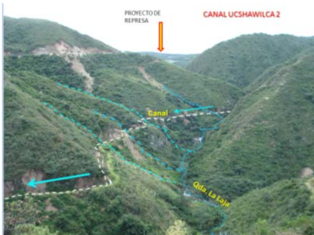
FOTO 5: Panorámica de la zona de toma y Canal Uchawilca 2 (de derivación)
