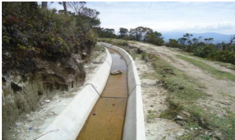
FOTO 1: Tramo revestido del canal Ocshawilca, a la altura del Km 6+200 (Q : 100 lps aprox.)
