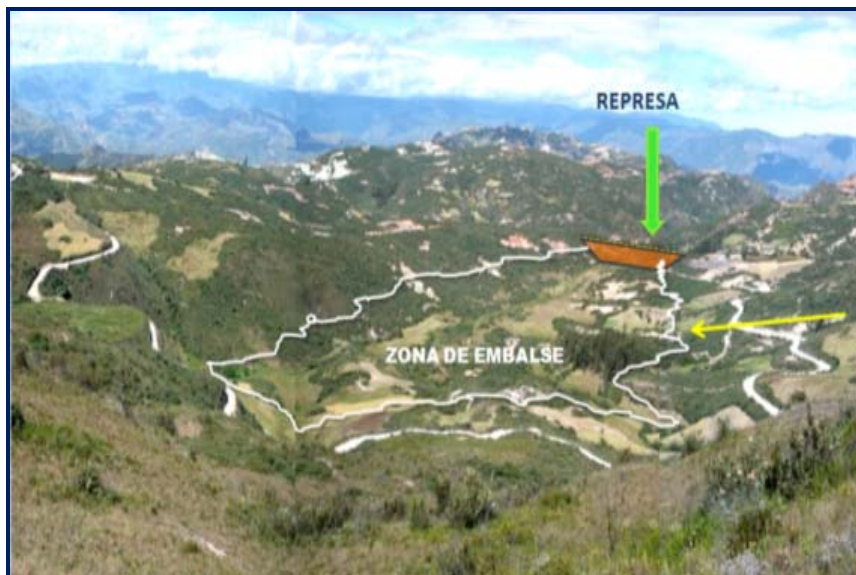
FOTO 5: Panorámica de la zona de embalse La Colmena, visto hacia aguas abajo.
