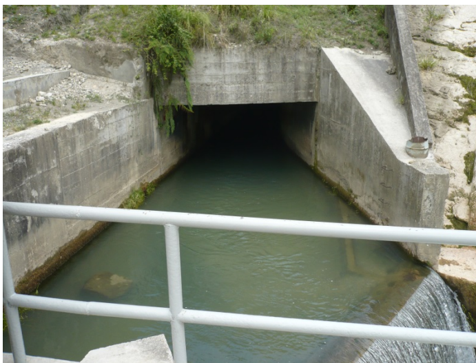
Portal de salida del Túnel Conchano Lugar para bocatoma proyectada
