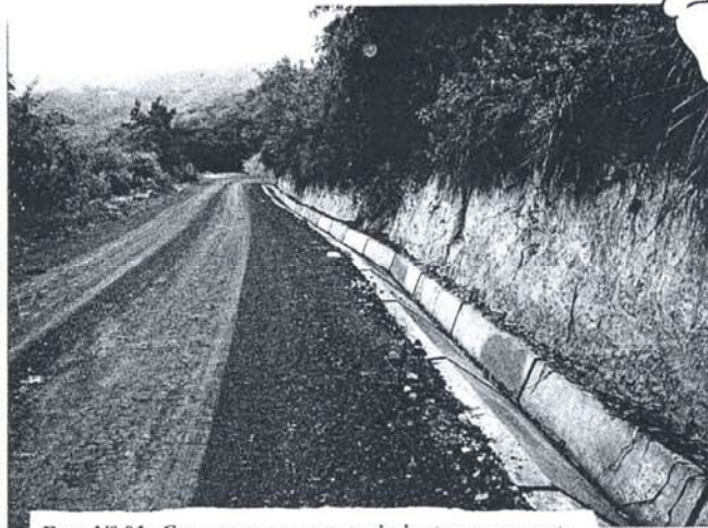
Foto N° 01: Carretera con mantenimiento permanente
