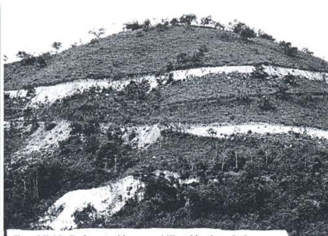
Foto N° 05: Reforestación y estabilización de taludes
