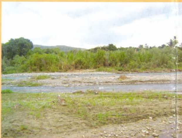
Foto N° 04. Zona crítica, cruce con quebrada Jaén.
