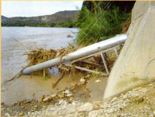
Foto N° 01. Zona de bombeo de agua a la poza de disipación.
