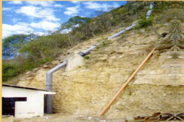
Foto N° 02. Las obras generan mayor desarrollo para los pueblos.
