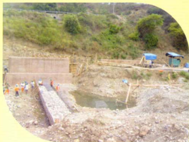
Foto N° 01. Zona de captación de agua (Bocatoma)
